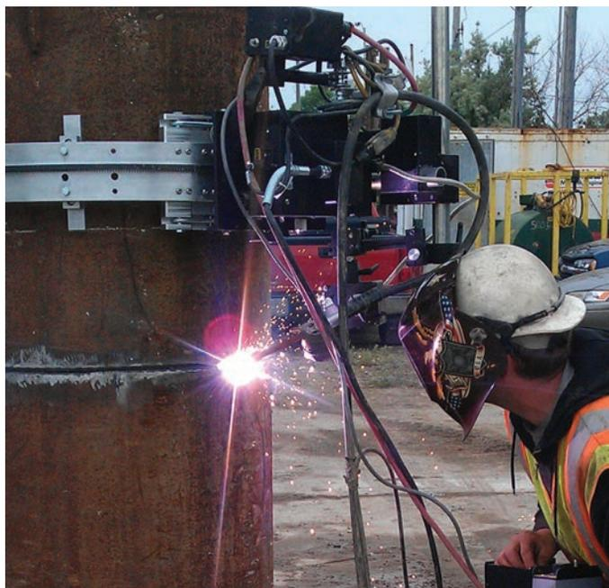
Изогнутый жесткий рельс (BRR) и кольцевые рельсы для работ по окружности (стр. 4-5)
