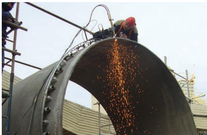
Hi-Flex рельс (FMD) для работ по окружности и неровных поверхностей до 30 д. (760 мм) радиусов. (Стр. 2)
